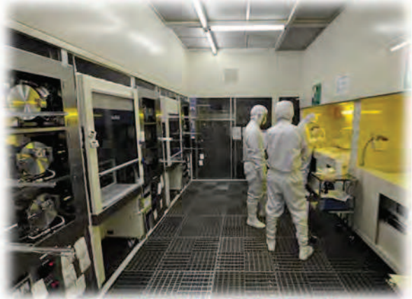
ケミカルフィルター設置のスーパークリーンルーム (クラス10, 0.1μm)
