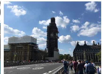
工事中のビッグベン
