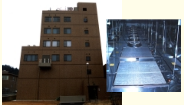
平成11年度国立学校優秀施設表彰文教施設部長賞(技術部門)受賞の新研究棟ならびにケミカルフィルター設置クリーンルーム
